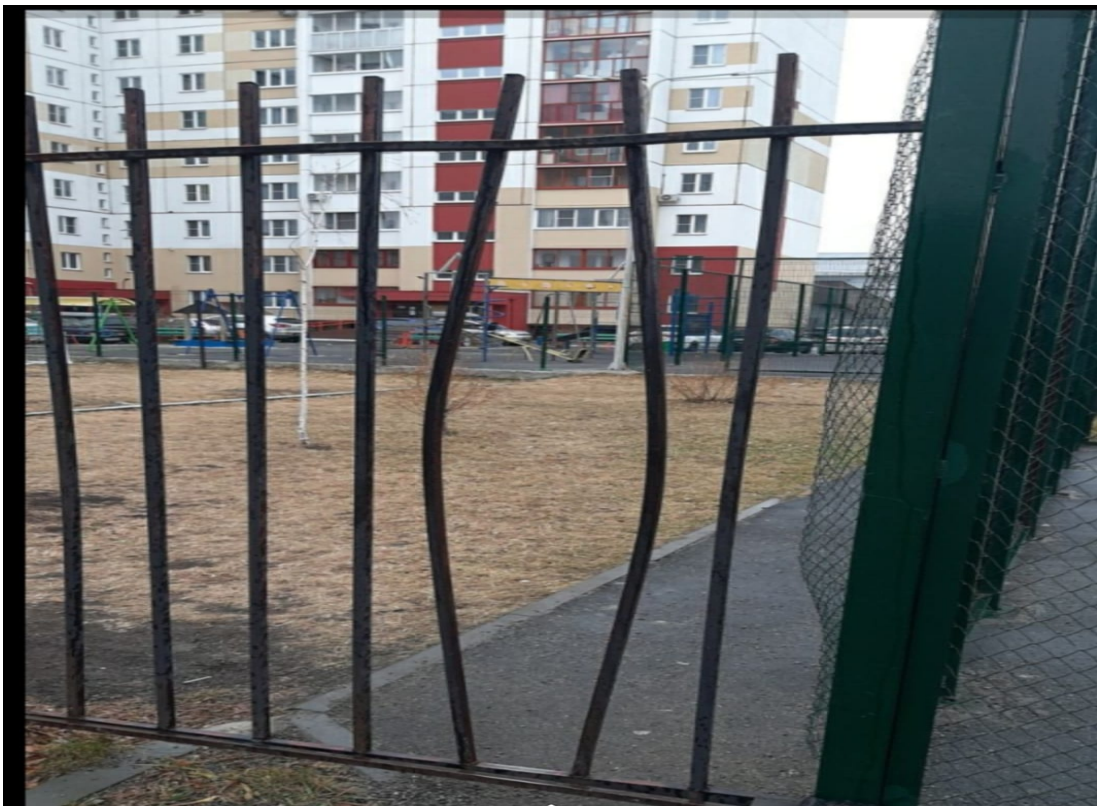
Ремонт ограждения придомовой территории
